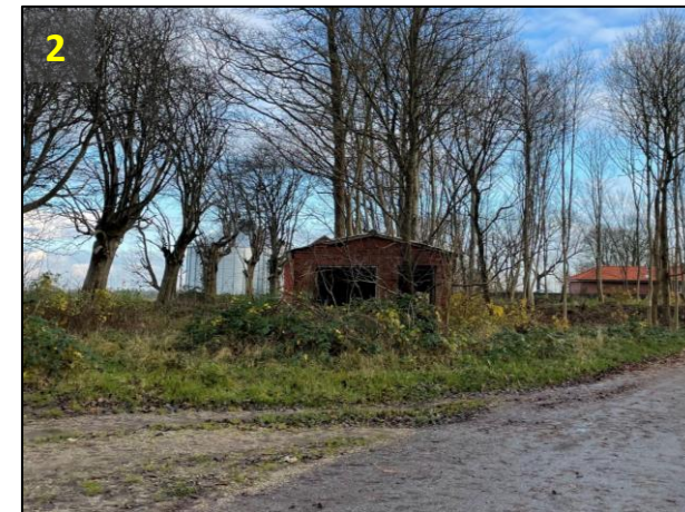
Gammelt frysehus til nedrivning og etablering af indgang/passage til stisystem.
